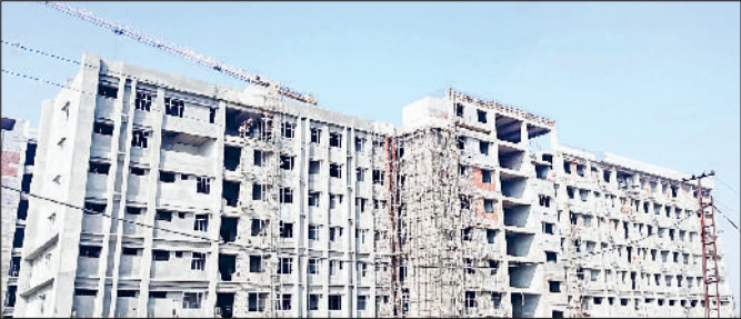
फतेहाबाद। निर्माणाधीन सरकारी अस्पताल की बिल्डिंग, जहां बनेगा सरकारी हॉस्टल।
